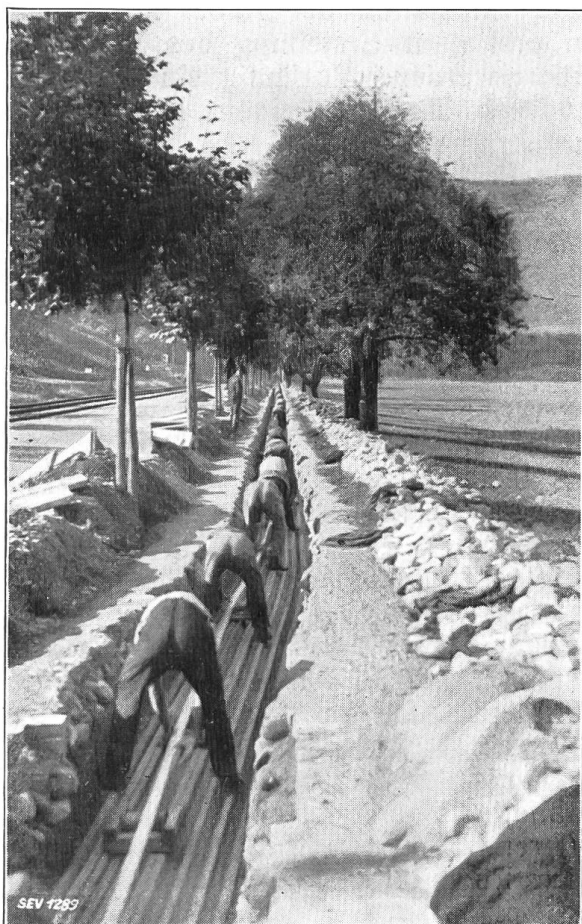
Fig. 4. Einziehen der Kabel.
