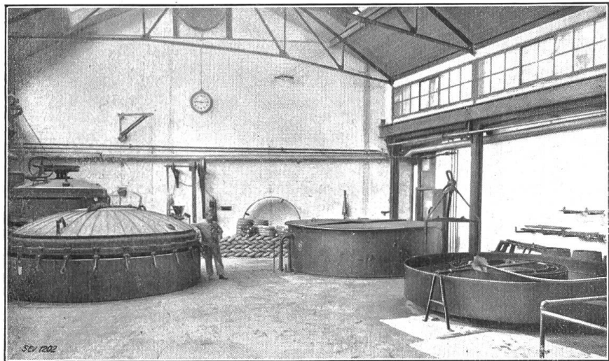
Fig. 7. Vakuumtrocken- und Imprägnierkessel.
