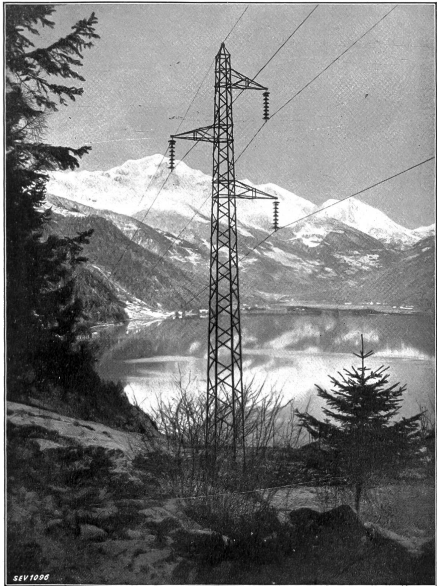
Fig. 13. 140 kV-Leitung Cavaglia-Campocologno, Tragmast No. 61 am Puschlaversee.
