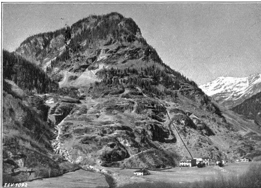
Fig. 4. Kraftwerk Robbia. Gesamtansicht.
