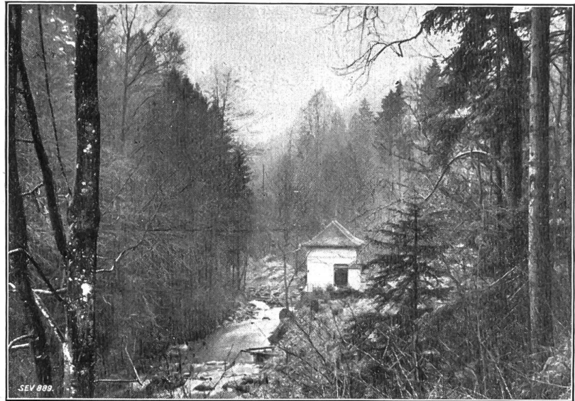
Fig. 11. Bedienungsloses Wasserkraftwerk Hofen des E.W. der Stadt St. Gallen. Aussenansicht.
