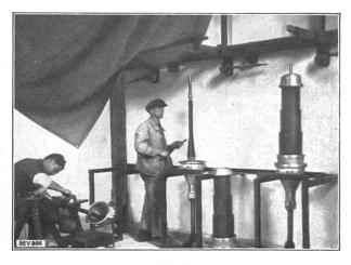
Fig. 8. [Montage der Kabelendverschlüsse an 50 kV Kabeln der Kraftwerke Oberhasli A.-G.
