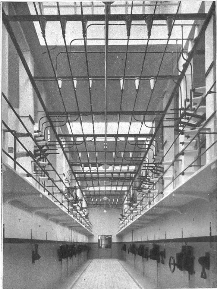
Fig. 11. Poste de Montcherand. Vue du couloir central.
