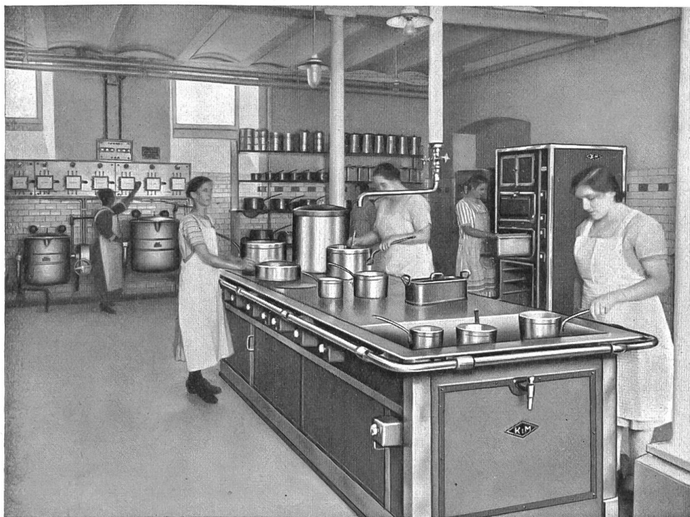
Elektrische Grossküche im Krankenhaus Liestal mit einem Anschlusswert von 83,7 kW.
