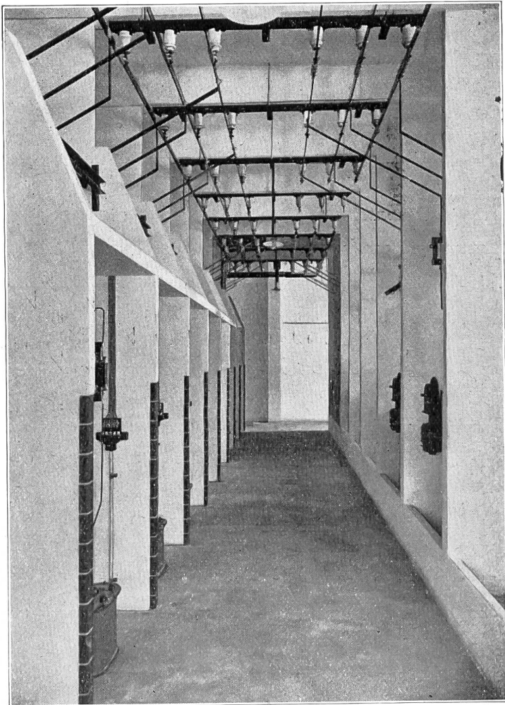
Fig. 22. Barres collectrices à 5600 volts.
