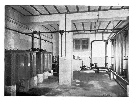
Fig. 11. Oelkeller mit Schmutzölgefässen und Oelschleuder.
