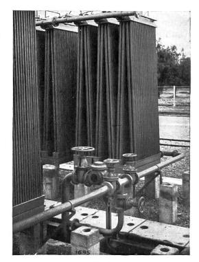
Fig. 9. Ansicht einer Kühlgruppe mit Oelabflussleitungen und Oelströmungsmesser.
