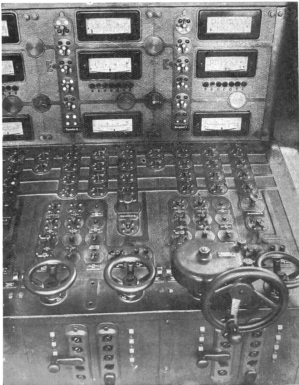
Fig. 31. Schaltbühne: Blick auf das Generatorenschaltpult.
