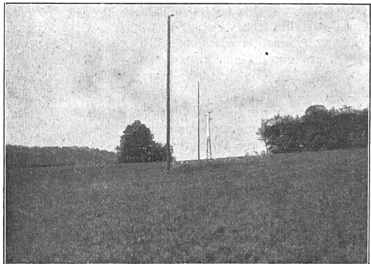
Abb. 2. Schablonenhaft durch einen Waldrand geschlagene Schneise. Die links stehen gelassene Baumreihe hätte zum Mindesten entfernt werden sollen. Leitung im Baustadium.
