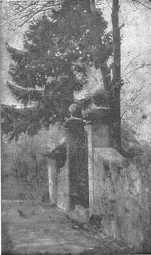
Abb. 3. Portal des alten Friedhofs von Ollon, vor Aufstellung eines Transformators.
