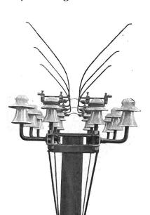
Abb. 28. Freileitungs-Sicherung der A.-G. Sprecher & Schuh.
