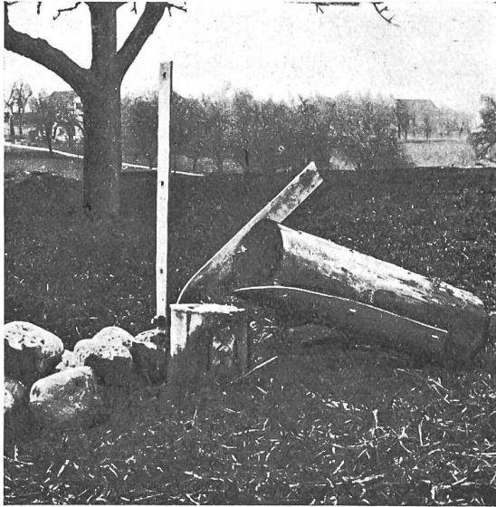
Fig. 5. Vom Sturme umgeworfene Stange auf Kastler-Sockel
