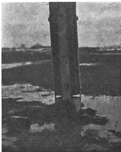
Fig. 4. Vom Winde schiefgedrückte Stange auf Kastler-Sockel
