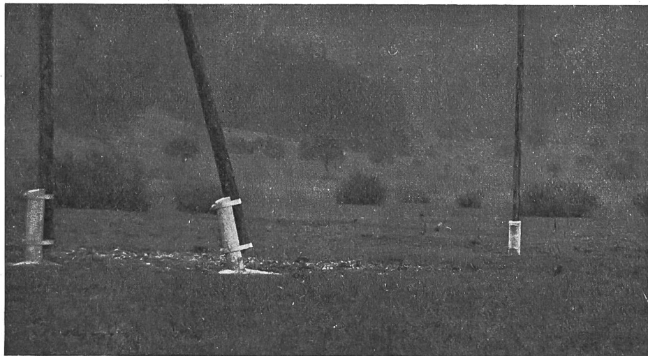
Fig. 9. Leitung auf „Universalsockeln“ durch Sumpfgebiet.
