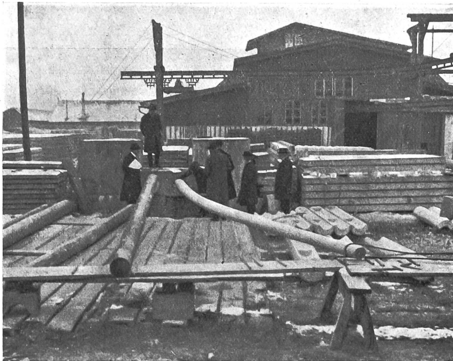
Fig. 10. Anordnung der Belastungsversuche mit „Universalsockeln“.
