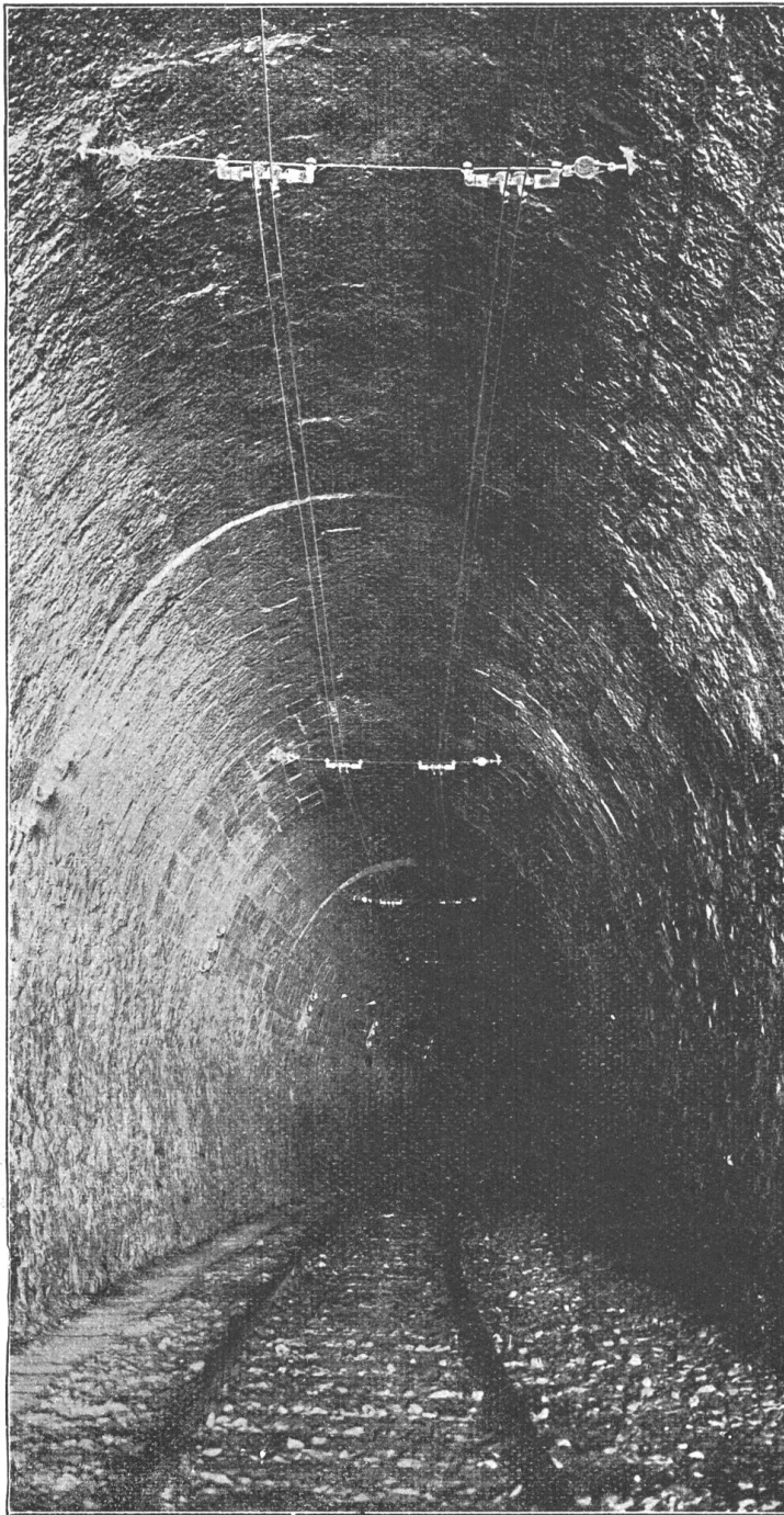
Abb. 14. Anordnung der Kontaktleitung im Tunnel.
