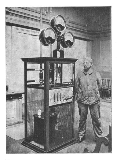
Abbildung 6. Apparaturkasten mit Transformator, Drosselspule, Elektroden und automatischer Regulierung samt aufgebauten Messinstrumenten für Demonstrationszwecke.
