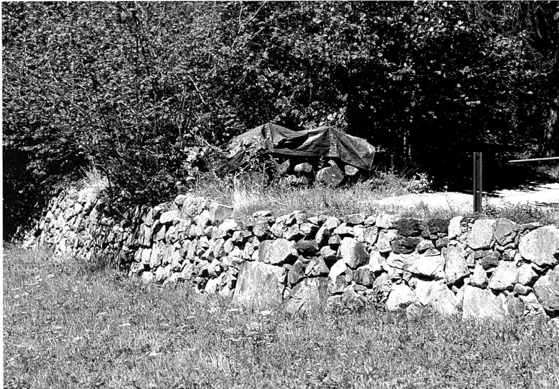
Abb. 3. Eine der südexponierten Lesesteinmauern am Rande der Mähwiesen bei Garbela (Val Poschiavo), an welcher Troglophilus cavicola gefunden wurde (Foto: H. Baur).
