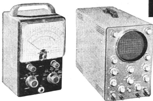
**V-7A Röhren-Voltmeter** für Gleich- und Wechselspannung sowie Widerstandsmessungen. Je 7 Meßbereiche von 1,5 bis 1500 V Endauschlag. Skala für Spitzen-Spannungsmessung. Bausatz Fr. 163.—, montiert Fr. 212.50.
