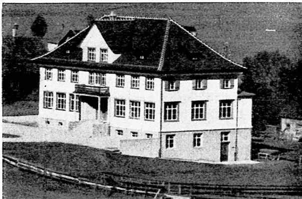
Neues Schulhaus Eggerstanden.
