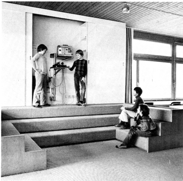
Projektionsschrank hinter Sitzstufe
