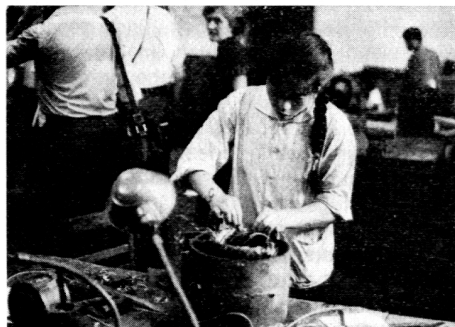
Schülerin beim Motorenwickeln in der Werkstatt.
