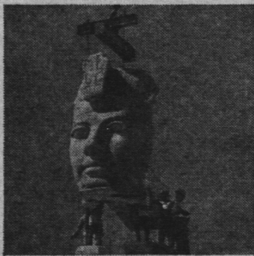
Die Felsstatuen von Abu Simbel mussten wegen des Assuan-Staudammes 65 Meter weiter nach oben umziehen. Der Transport der bis zu 30 Tonnen schweren Sandsteinblöcke war erst möglich, nachdem man mit Araldit Stahlanker eingeklebt hatte.
