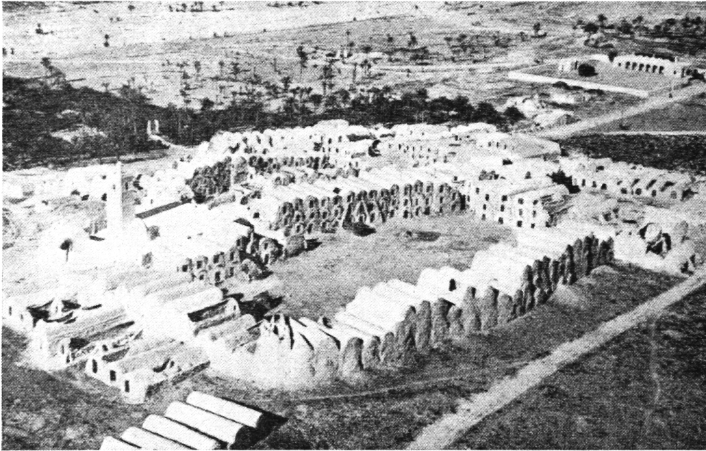
Abb. 8: Altstadt von Metameur. Die Türen der Wohnungen führen auf einen runden Platz. Die Häuserrückseiten bilden eine geschlossene Mauer
