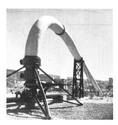
Der Erddampf ist gefaßt und wird den Fabriken im Hintergrund zugeführt. Die Röhren sind isoliert und ziehen sich stellenweise kilometerweit hin
