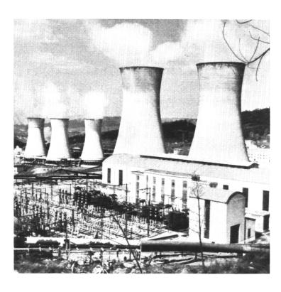
Elektrische Zentrale Larderello Nr. 3, dahinter Larderello Nr. 2. Im Vordergrund verläuft eine große Erddampfleitung, die von rechts her mit fünf andern der großen Maschinenhalle zugeführt wird. Vor dieser liegt die Schalt- und Umformerstation, dahinter sind zwei von den vier riesigen Kühltürmen sichtbar. Diese Zentrale arbeitet mit natürlichem Dampf, während die dahinter liegende, ältere noch mit Wärmeaustauschern versehen ist.
