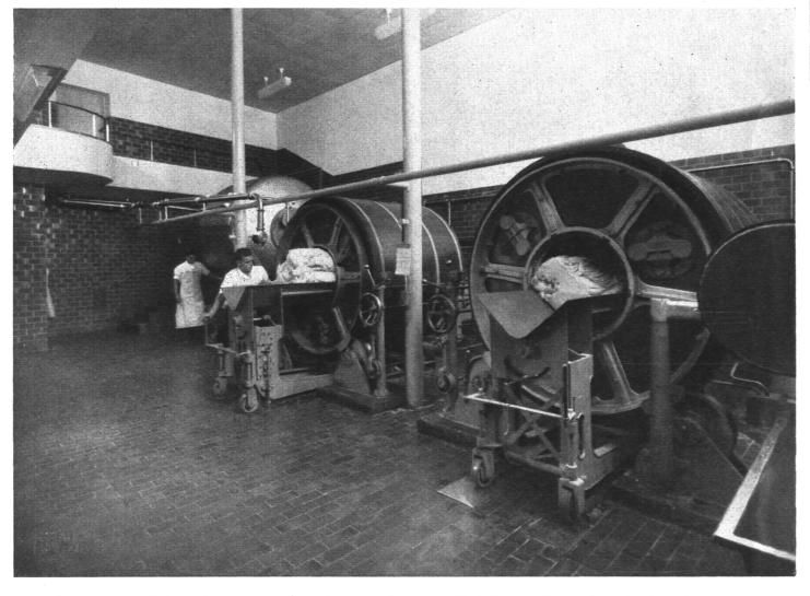
Im größten dieser drei Butterfässer können pro Butterung bis zu 2500 l Rahm gerührt und zur fertigen Butter geknetet werden. Die Temperatur des Rahmes und des Waschwassers, sowie die Laufzeiten und Umdrehzahlen des Butterfertigers, werden vom Butterer genau überwacht.
