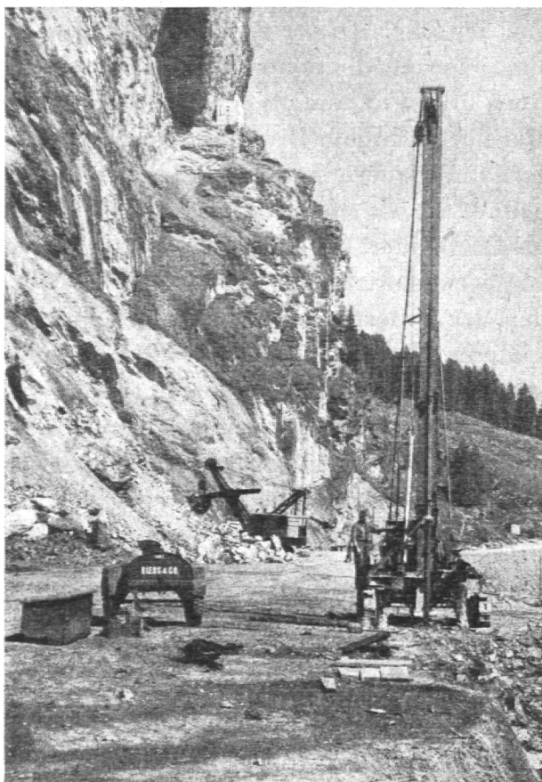
Die moderne Bohrmaschine, auf Raupen selbstfahrend und unabhängig von Preßluft. »Schlagzeug T 22«. Oben im Fels die Burgruine Marmoréra.
