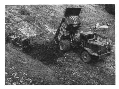
Bild eines Euclids mit gekippter Ladung von 12 m<sup>3</sup>.
