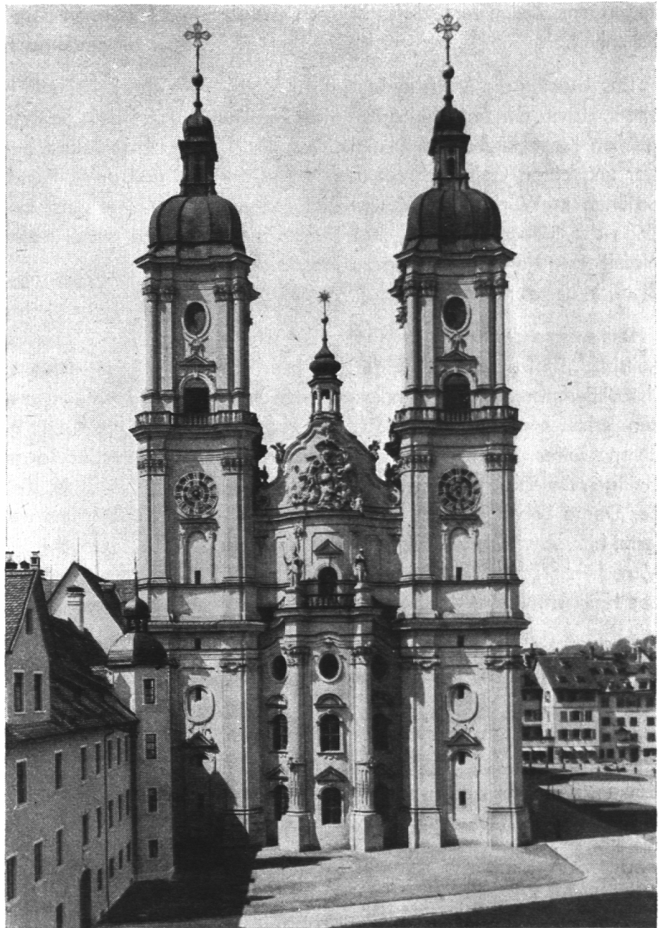
Ostfassade Kloster St. Gallen
