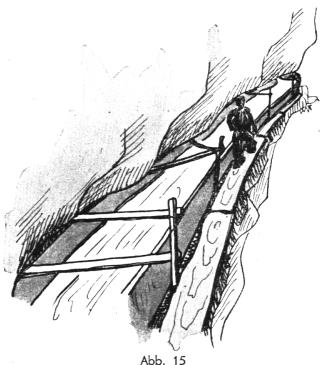
gedichtet. Daneben schmaler Weg für den Wasservogt. Vergleiche Abb. 15. — Heute z. T. Kännel durch eiserne oder Zementröhren ersetzt. Streckenweise auch Stollen. Den Anfang im Stollenbau machten die Visperterminer, indem sie die älteste Wasserfuhre zum modernen Tunnel umbauten. In neuester Zeit Durchstich des Riederhorns, um das Wasser des Aletschgletschers der Gemeinde Ried-Mörel zuzuführen. Abtretung des Aletschwaldes an den Bund durch die Gemeinde. Unterstützung durch Bund und Kantone.
