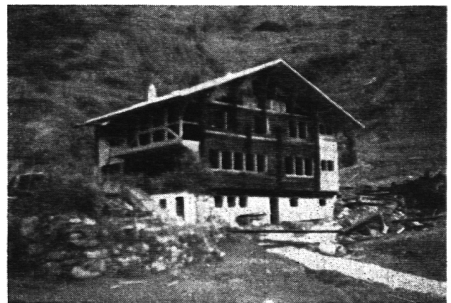
Eine ehemalige Herberge für Gotthardsäumer bei Gurtellen wird in die Bergheimatschule umgebaut.
