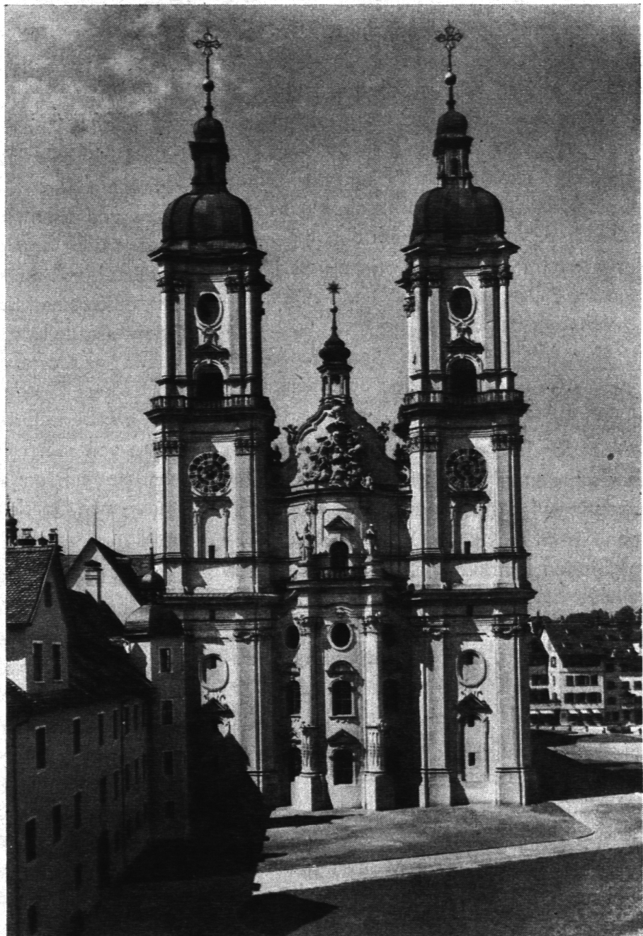
TURMFASSADE DER ST. GALLER KATHEDRALE
