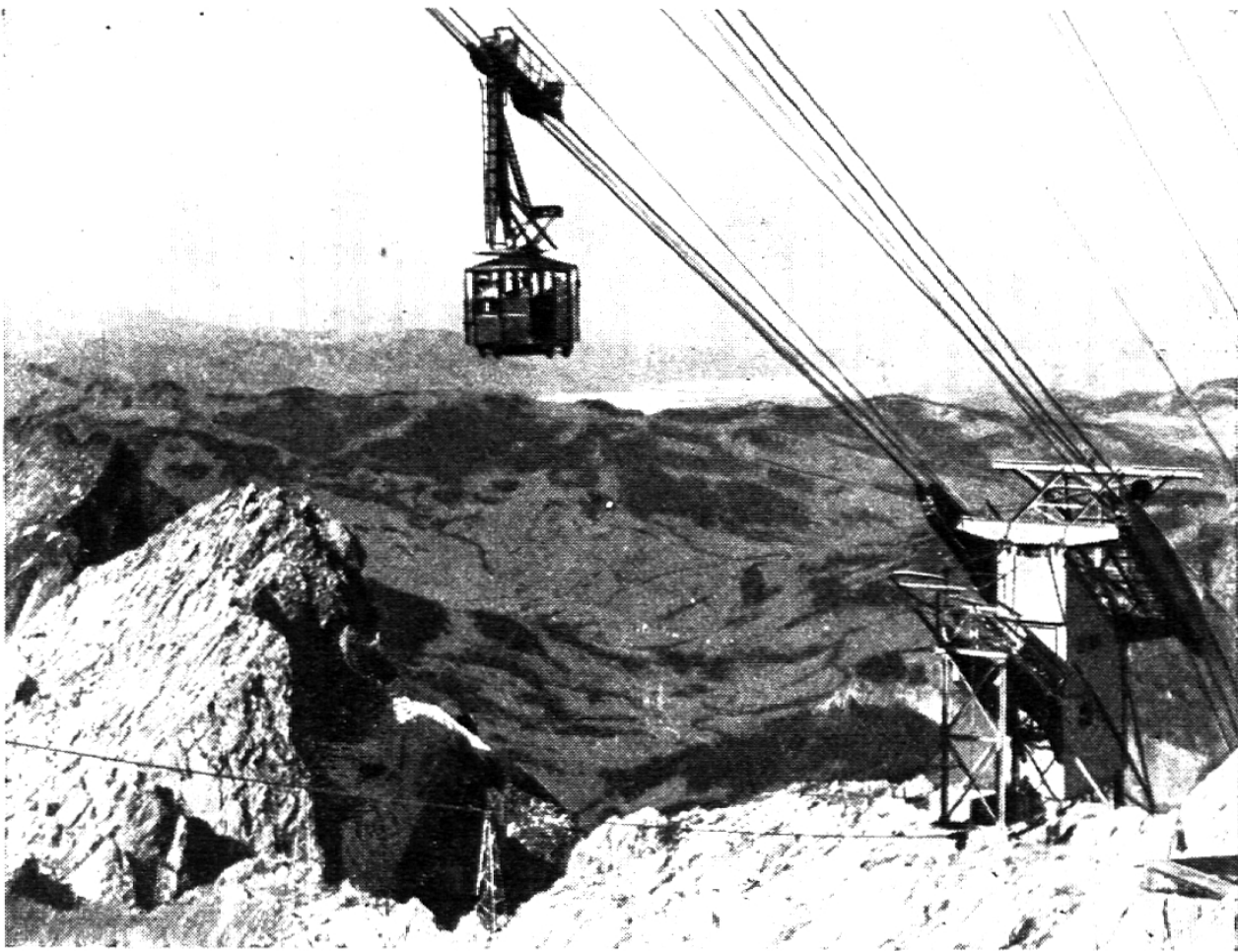
Stützfeiler der Sântisschwebbahn mit Blick gegen Westen
