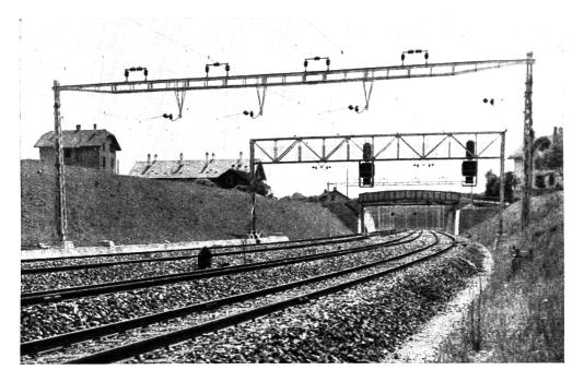
Los 1: Blick auf den viergeleisigen Einschnitt gegen den Bahnhof Bern, mit normalem Tragwerk, Signalpasserelle und Ueberführung des Polygonweges. (Nr. 4068. B R B 3. 10. 39. Fotodienst S B B.)
