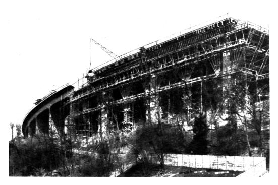
Los 2: Bau des Viaduktes über die Talwegmulde, links fertiger Teil, rechts Gerüste mit Turmdrehkran.
