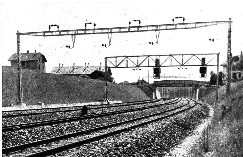
Los 1: Blick auf den viergleisigen Einschnitt gegen den Bahnhof Bern, mit normalem Tragwerk, Signalpasserelle und Ueberführung des Polygonweges.
