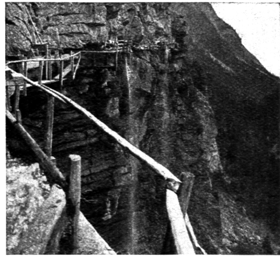
Bisse (Wasserleitung) von Savièse.
