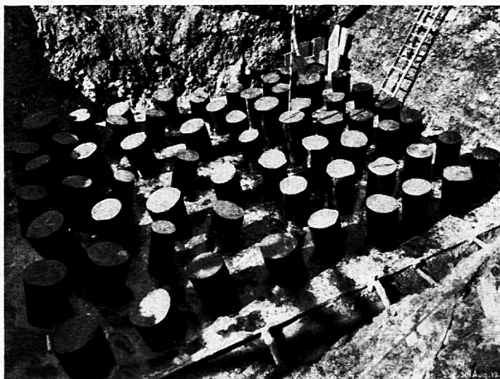
Eine Aufnahme über die Pfählung für die Brückenpfeiler
