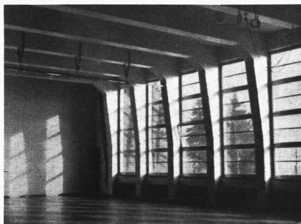
Halle in Eisenbetonkonstruktion.
