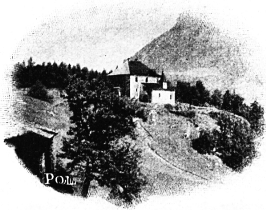
Schlösschen Beroldingen. (Am Wege nach Bauen.)
