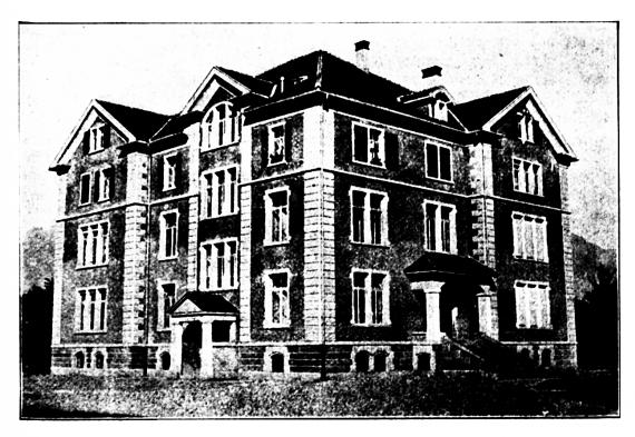
mit 4 Zimmern, Küche und Abort. Im Hause ist elettrische Beleuchtung, Wasserleitung bis zur Abwartwohnung und damit verbundene Spühlung der Aborte. Die Heizung geschieht durch Dampswasser; sie ist montiert von Firma Stehle und Gutknecht in Basel und sind 2 Heizkörper, ein größerer und ein kleinerer zur Berfügung und ist Heizung sämtlicher Lokalitäten des Hauses möglich.
