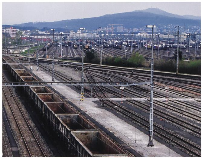
Der Rangierbahnhof Limmattal ist der grösste in der Schweiz. Die Wagons werden auf der oberen Ebene von den Zügen abgekoppelt und gleiten dann computergesteuert auf die untere Ebene, wo sie in die neu zusammengestellten Züge zur Weiterfahrt integriert werden.
