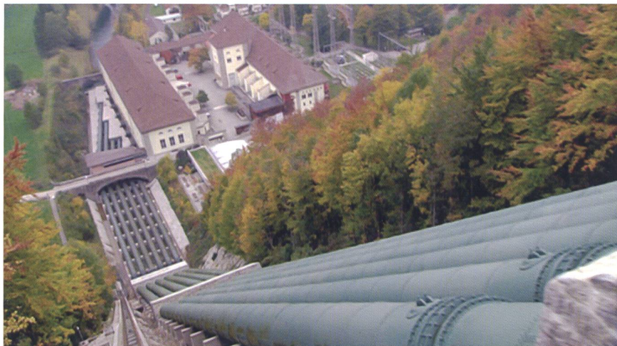
Je grösser die Höhendifferenz zwischen Stausee und Turbine, desto mehr Energie lässt sich mit der gleichen Wassermenge produzieren.
