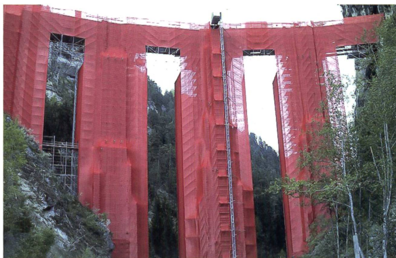
Der weltberühmte Landwasserviadukt steht schon 106 Jahre. Er wird saniert und von Mai bis September in ein rotes Kleid gehüllt. Das Baudenkmal wird vorübergehend zum Kunstwerk.
