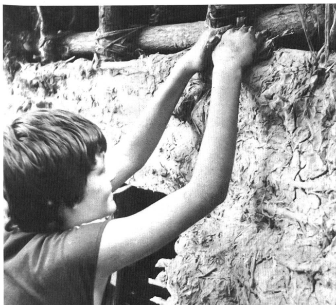
Beim Einkneten der Lehmwickel in die Rutenflechtwand im Bereiche des Eingangs ins Häuschen.
