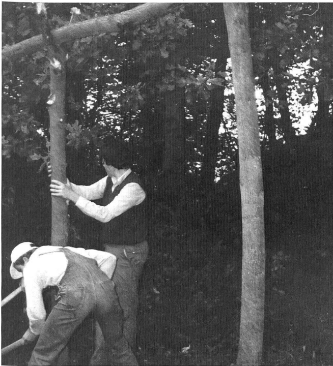
Ein Firstständer wird gesetzt...
