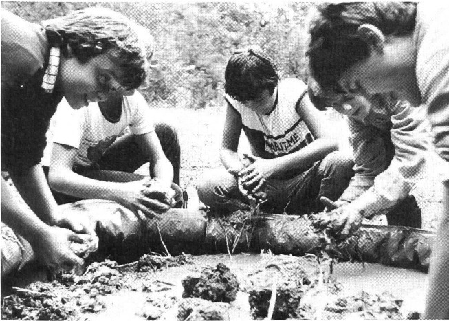
Eine eindrucksvolle Gemeinschaftsarbeit ist das Kneten von Lehmwickeln und das Füllen der Rutenflechtwände.
