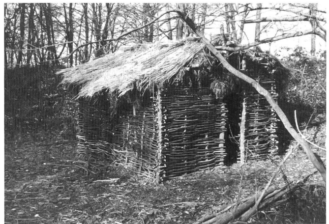
Die fertig geflochtenen Rutenwände. Auf dem Dach fehlt noch die Schilfstrohschicht.
