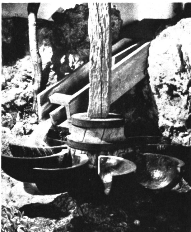
Löffelräder, welche besonders in Gebirgsgegenden (kleine Wassermengen und grosse Gefälle) zur Anwendung gelangten, gelten als Vorläufer der Peltonturbinen. (Originalrad einer um 1850 gebauten rumänischen Mühle.)
