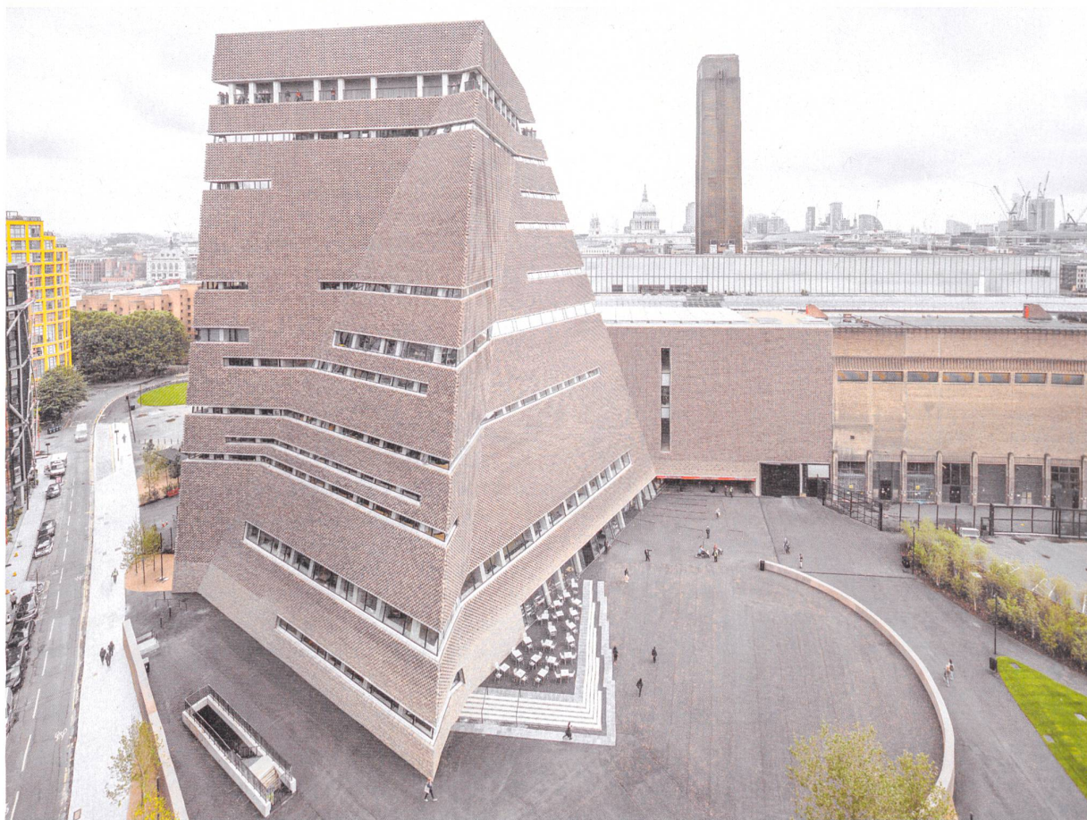
Das perforierte Mauerwerk – von der tragenden Funktion befreit – hüllt die nach innen und aussen gefalteten Flächen der verdrehten und scharfkantigen Pyramide ein wie ein Schleier aus Steinen.
