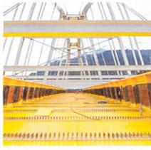
Die Stahlkonstruktion der neuen Eisenbahnbrücke Massongex vor dem Betonieren des Fahrbahntrogs.
