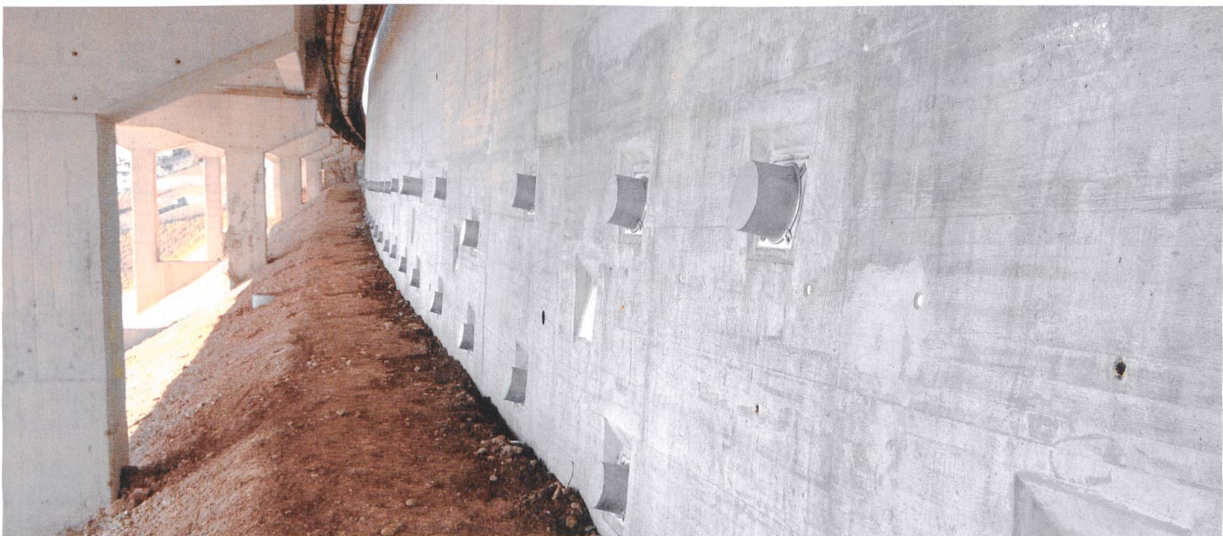
Oben: A9 bei Le Lanciau VD: Verstärkung einer bergseitigen Nagelwand mittels vorgespannter Ankerwände.
