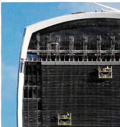
Die Südfassade mit nachträglich montierten Sonnenschutzlamellen .
