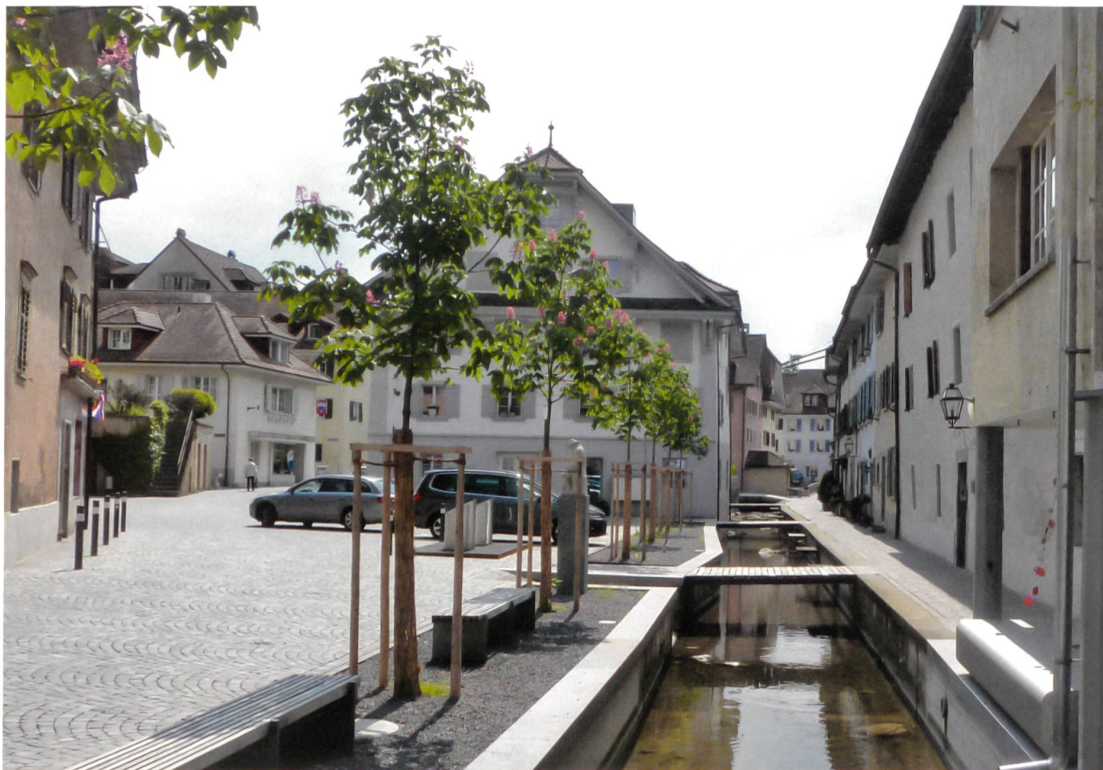
Sursee mit sanierter Altstadt und optimiertem Kanal: ein Masterplan zur Verbesserung des Hochwasserschutzes an der Sure.
