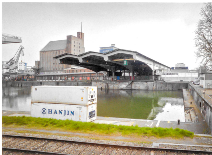
Wahrzeichen im Kleinhüninger Hafen: Das Bernoulli-Silo (1923–26) und der Umschlaghof (1952/53) mit seinem beeindruckenden Dachtragwerk.
