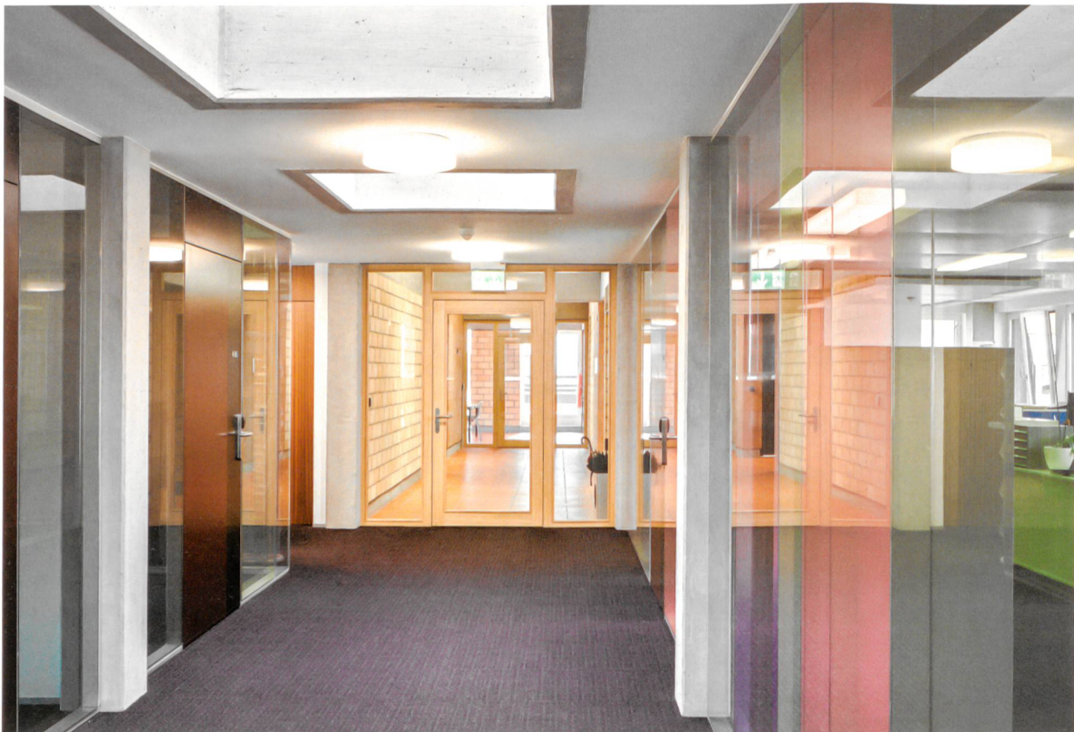
Die gläserne Welt des Bürotrakts trifft auf die Backsteinwelt der Halle. Die bestehenden Backsteine sind rot, die neuen gelb.
