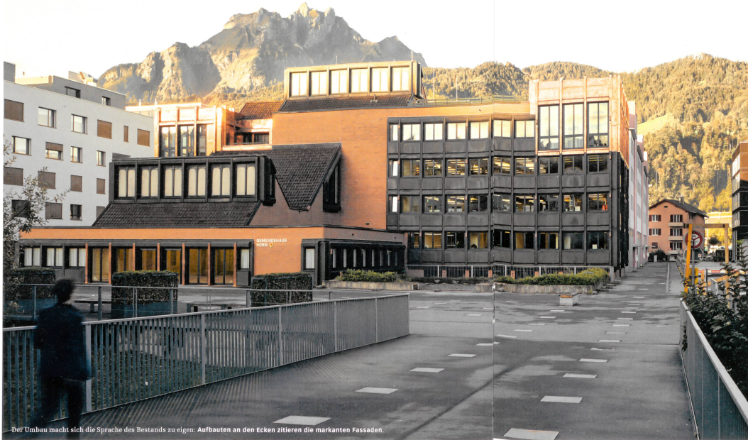
Der Umbau macht sich die Sprache des Bestands zu eigen: Aufbauten an den Ecken zitieren die markanten Fassaden.
